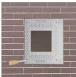
Atornille la luminaria a la pared Usando 4 tacos y tornillos
